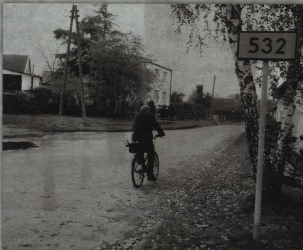
Ulica Piastowska, będąca częścią drogi wojewódzkiej nr 532, w najbliższych latach nie zostanie wyremontowana.
