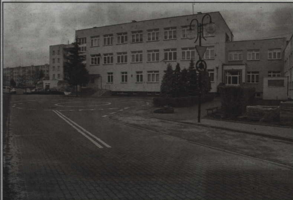
W przyszłym roku będą kontynuowane remonty w placówkach oświatowych. Główny wysiłek zostanie skierowany na wszystko, co wiąże się z bezpieczeństwem szkół.
