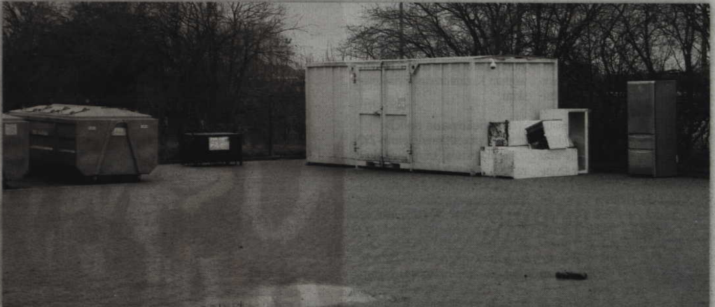
W inwestycji wartej prawie 240 tys. zł zapomniano o wodzie, prądzie, sanitariacie i pomieszczeniu socjalnym. Za pomieszczenie socjalne służy kontener na elektroniczne odpady ze starą kanapą w środku. Fot. Ryszard Bartosiak
