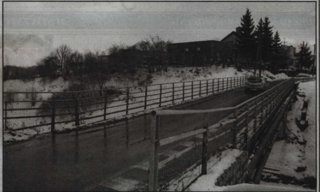
Nowy wiadukt będzie miał 45 metrów długości, chodnik i ścieżkę rowerową.
