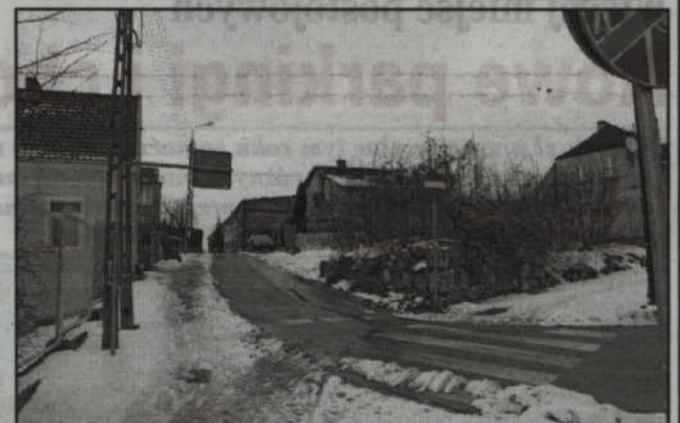
Ulica Żelazna będzie miała nową nawierzchnię. Inwestycja zostanie zrealizowana w tym roku. Fot. UMK
