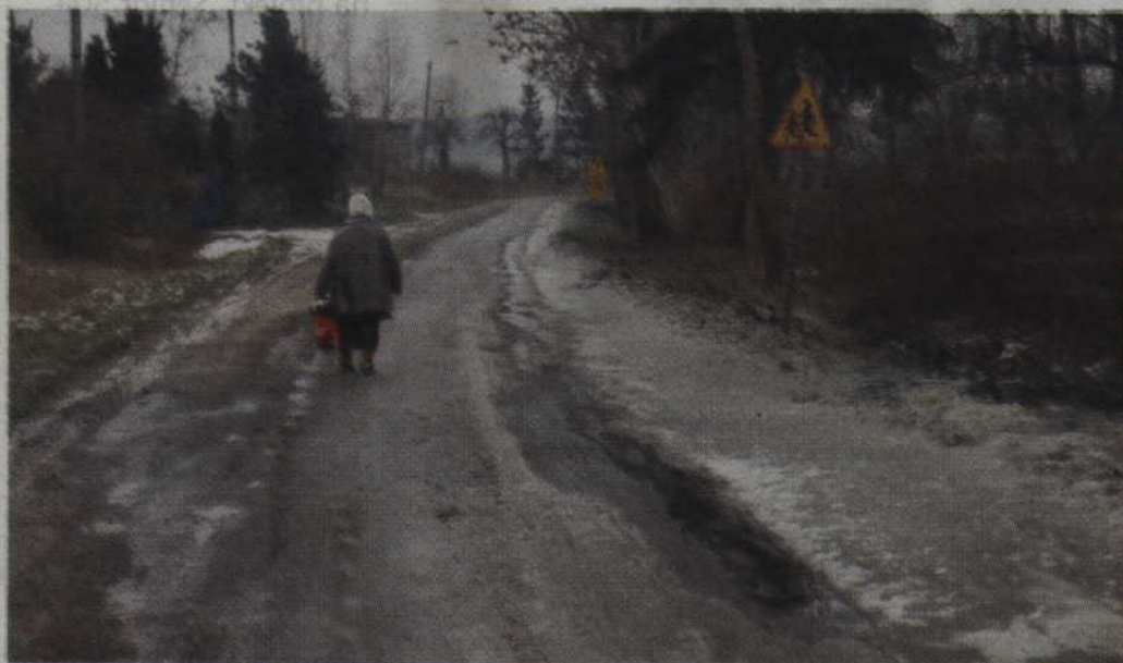
Zamarznięta woda z uszkodzonego wodociągu zagraża nie tylko pieszym ale również kierowcom.
