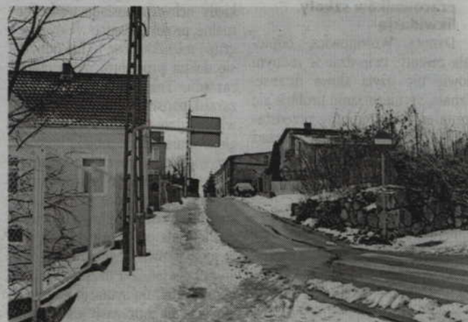
Modernizacja ulicy Żelaznej wyniesie ponad 980 tys. zł.
