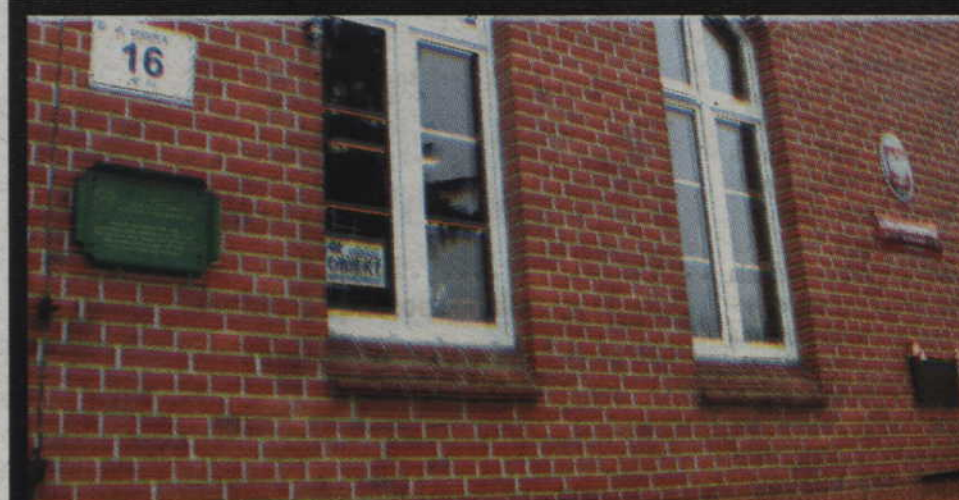
Niewielkie urządzenie zamontowane zostało na budynku głównym szkoły, od strony ulicy Staszica.
