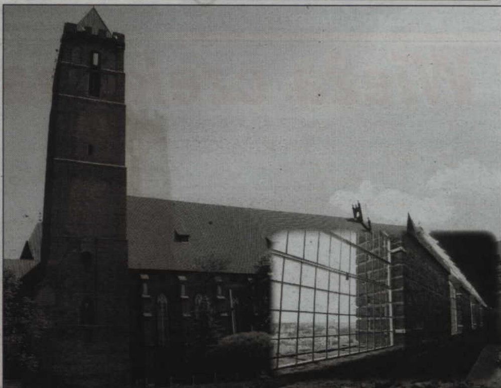
Wejście na wieżę kwidzyńskiej katedry jest już praktycznie gotowe. Trwają jeszcze prace organizacyjne, które pozwolą w sposób sprawny i bezpieczny udostępnić obiekt dla zwiedzających. Zdjęcia: archiwum UMK
