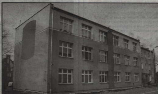
W budynku przy ul. Hallera, który dawniej był siedzibą szkół społecznych, powstaną łazienki dla bezdomnych mieszkańców miasta.
