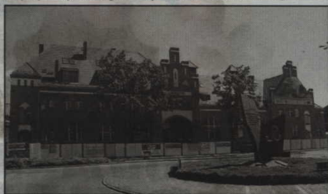
Trwają przygotowania do wielkiej przeprowadzki Biblioteki Miejsko-Powiatowej do modernizowanego budynku dworca kolejowego. Zdjęcia: UMK
