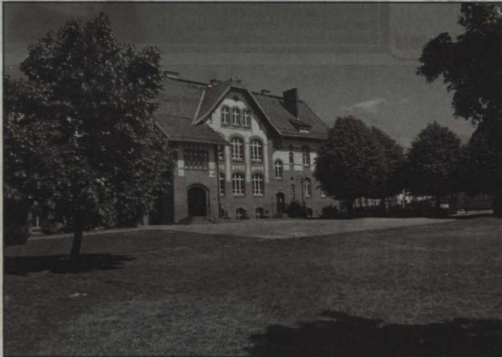
Zapadła decyzja o budowie boisk dla Szkoły Podstawowej nr 2. Wykonany został już projekt przedsięwzięcia.
