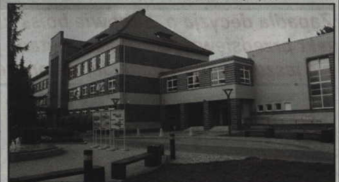
W Szkole Podstawowej nr 4 zaplanowano kolejne remonty łazienek.
