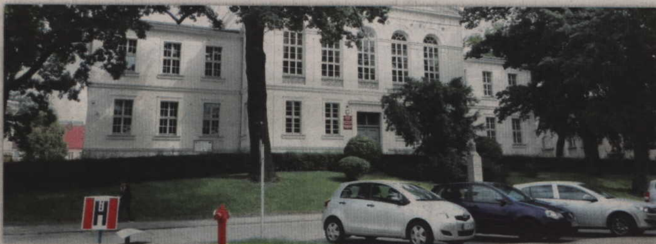
Prace związane z modernizacją ZSP nr 1 i ZSP nr 2 mają zostać zakończone z końcem września tego roku.
