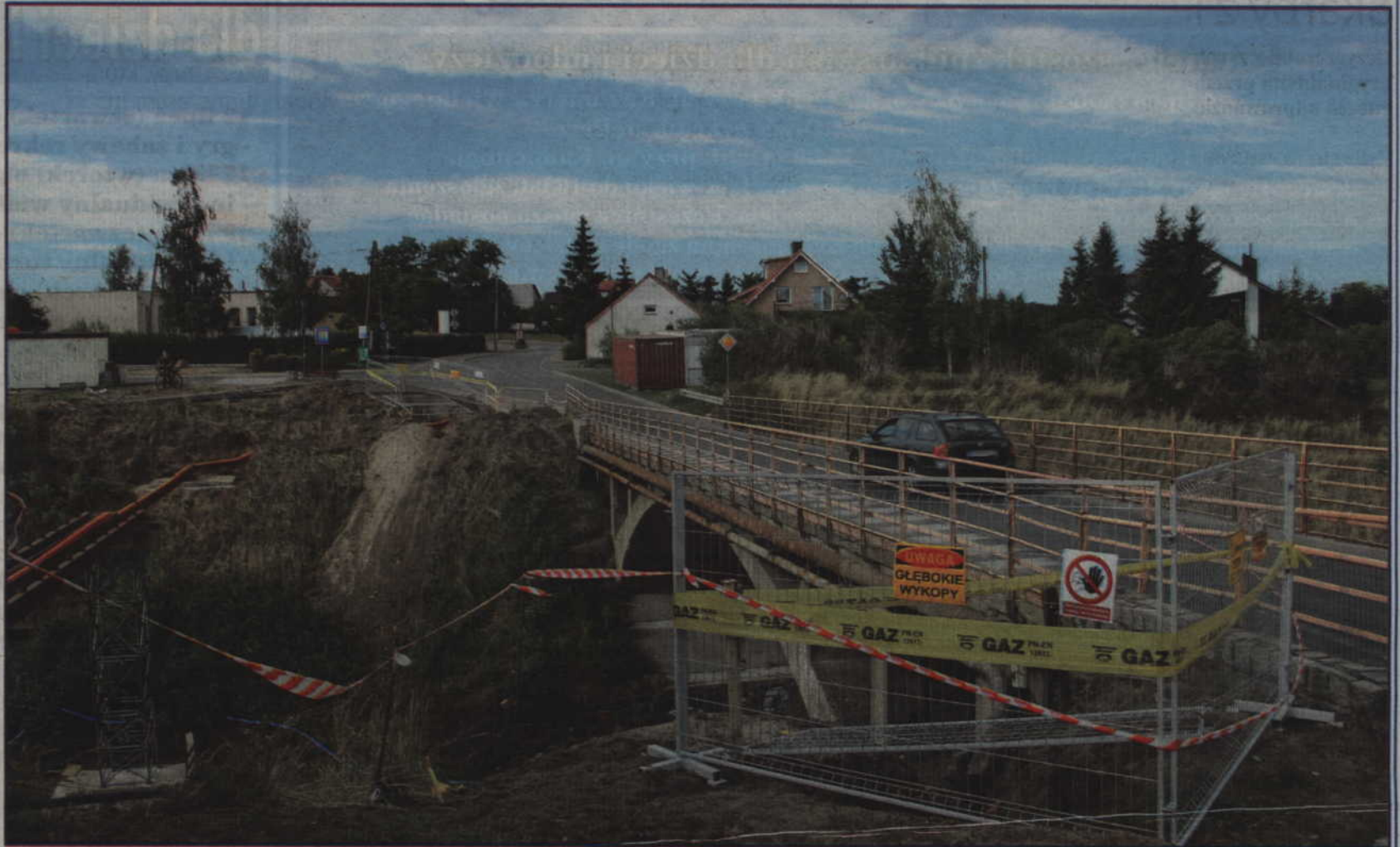
Stary obiekt zostanie rozebrany. Obecny most ma nieco ponad 30 m długości. Nowy będzie miał 45 metrów, a jego całkowita szerokość wyniesie 13,2 m, w tym szerokość jezdni 6 m. Planowane obciążenie mostu to 40 ton.
