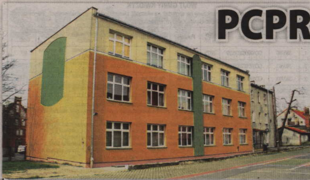
Trwają przygotowania do przeprowadzki Powiatowego Centrum Pomocy Rodzinie. Nową siedzibą powiatowej jednostki będzie budynek przy ul. Hallera.
