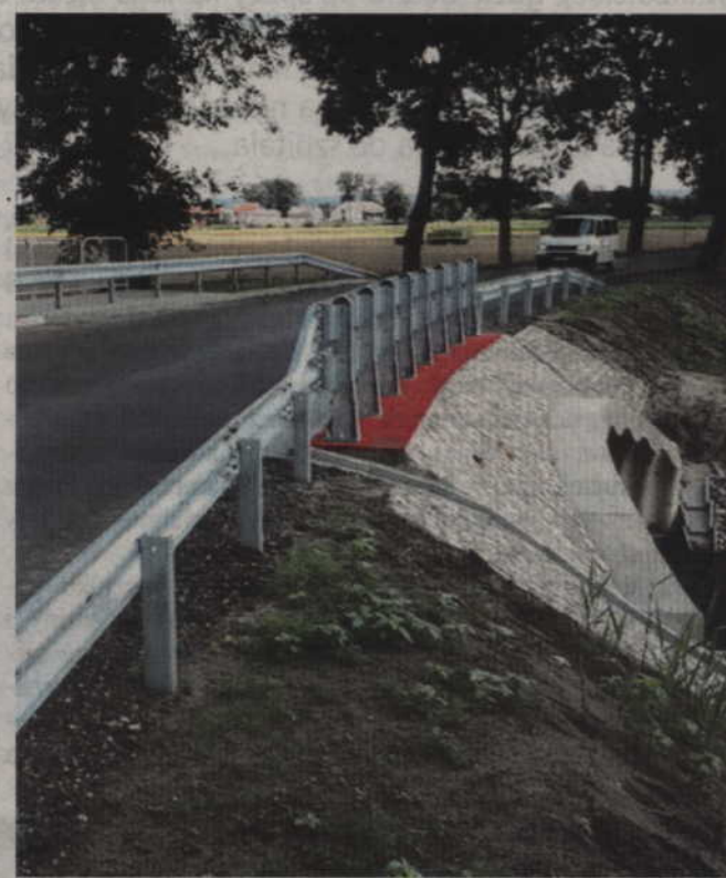
Budowa pochłonęła około 1,1 mln zł.
