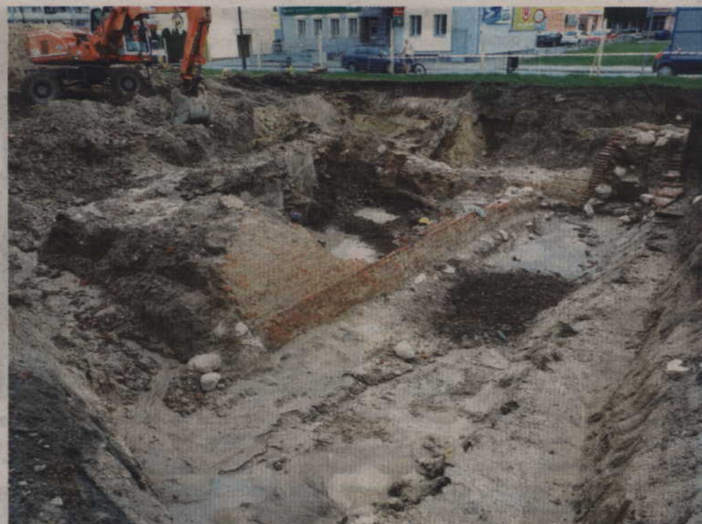
Po usunięciu warstw ziemi odświeżono fundamenty zniszczonej kamienicy.
