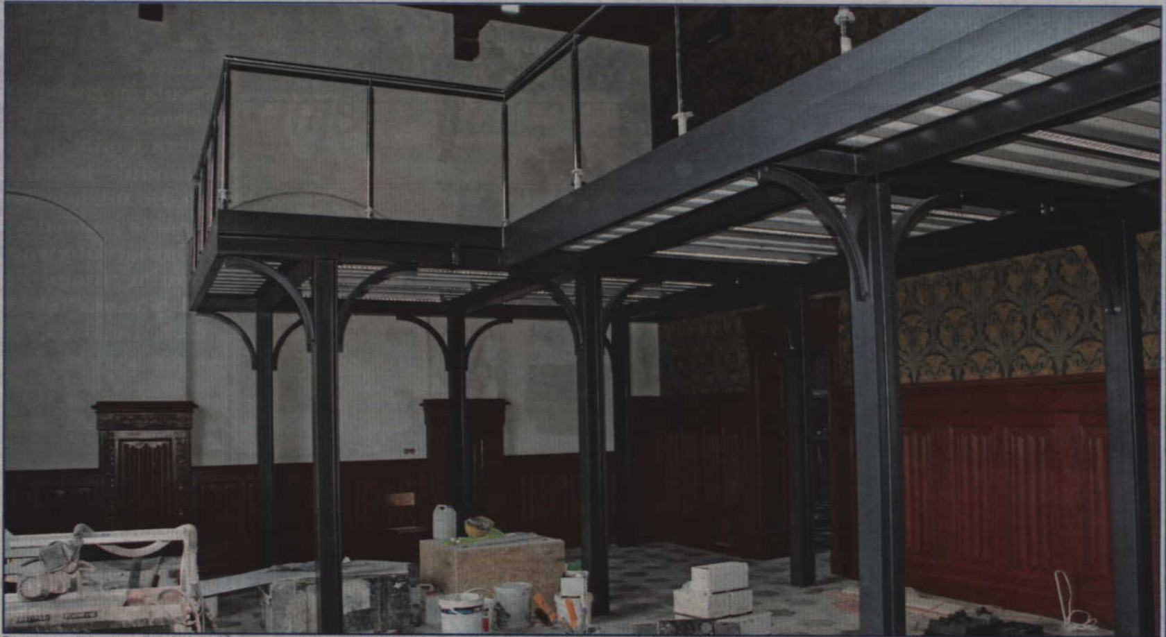
Trwają prace wykończeniowe w budynku dworca kolejowego. Rewitalizację zabytkowego gmachu wykonuje Spółdzielnia Produkcyjno - Usługowa „Rodło” w Kwidzynie.
