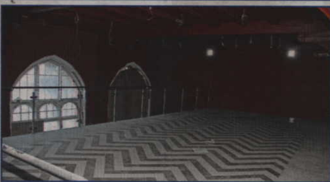
Inwestycja dobiega końca. W budynku trwają ostatnie prace wykończeniowe.
