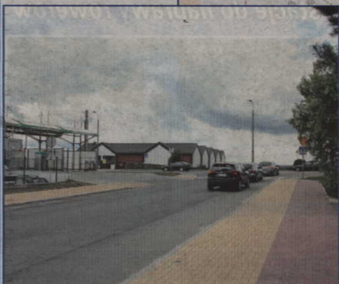
Przebudowane zostanie skrzyżowanie u zbiegu ulic Długiej i Malborskiej.
