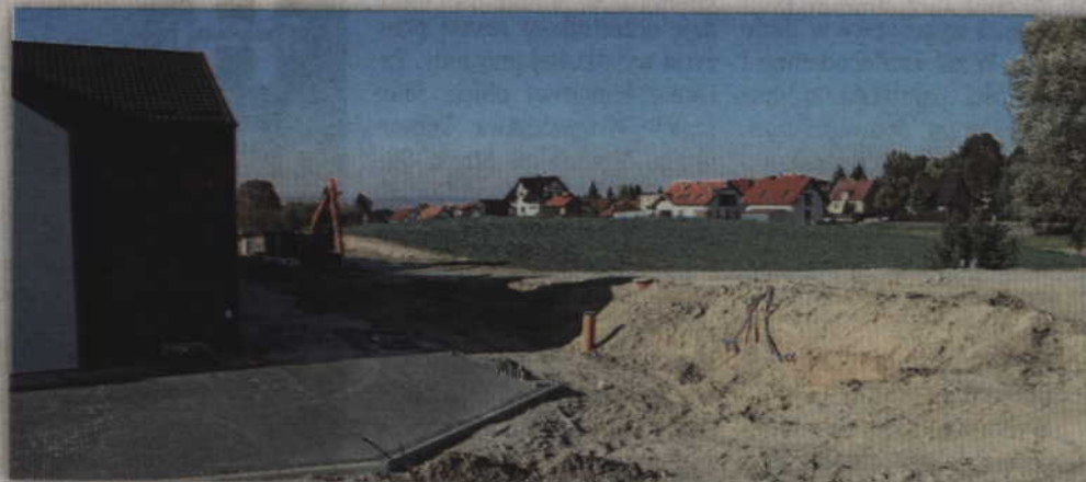
Trwa budowa nowej drogi, która będzie przedłużeniem ulicy Długiej.
