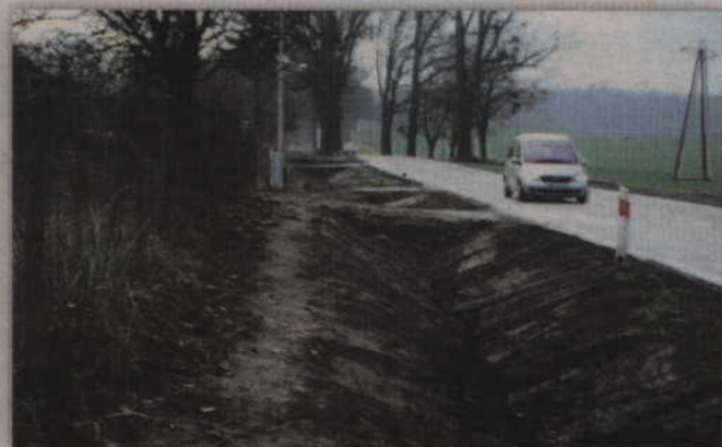
Przy okazji budowy zatoczek autobusowych czyszczone są również pobocza drogi. Fot. Ryszard Bartosiak
