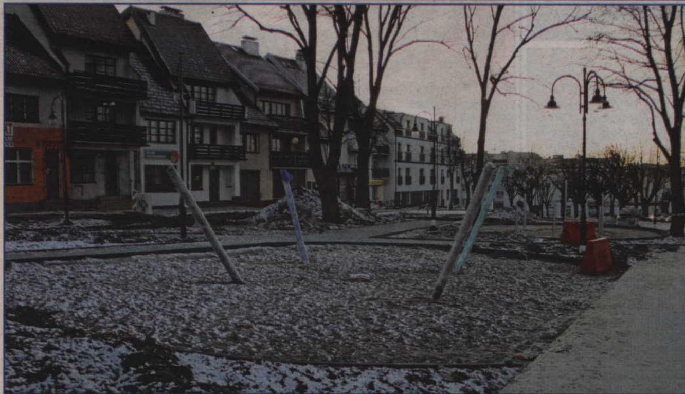
Zamontowana została już część podziemna, czyli między innymi zbiorniki i aparatura potrzebna do funkcjonowania tężni solankowej.
