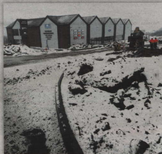
Prace przy budowie nowej drogi powinny zakończyć się na wiosnę.
