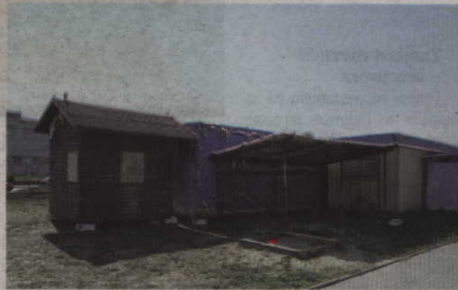
Dawnych „blaszaków” już nie ma, są za to... socjalne baraki.
