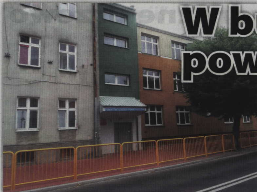
Szacowany koszt budowy windy w nowym budynku PCPR to ok. 350 tys. zł.
