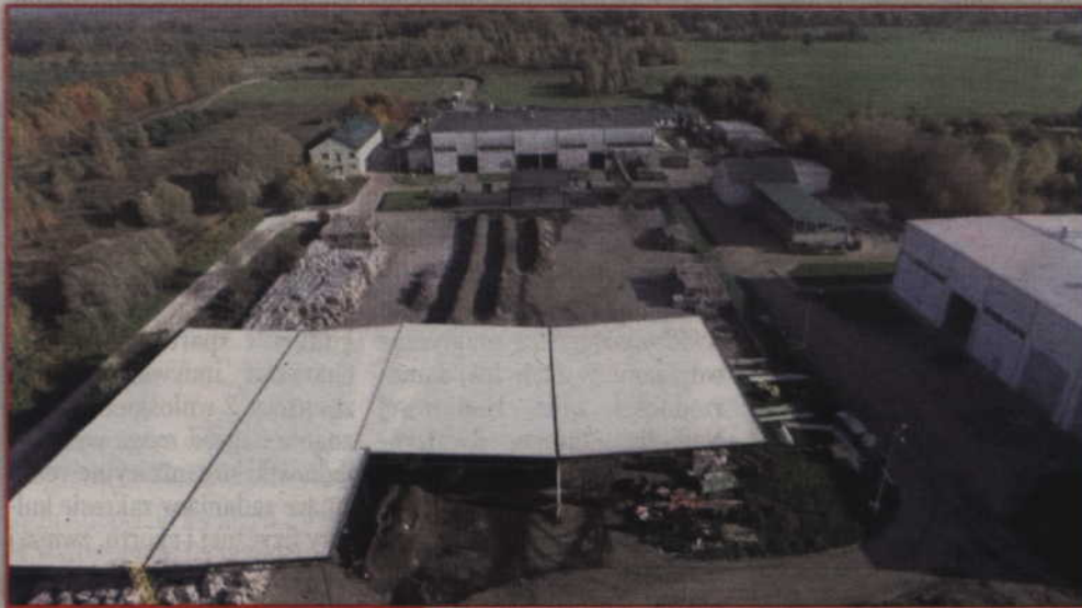
Zakład Utylizacji Odpadów w Gilwie Małej.
