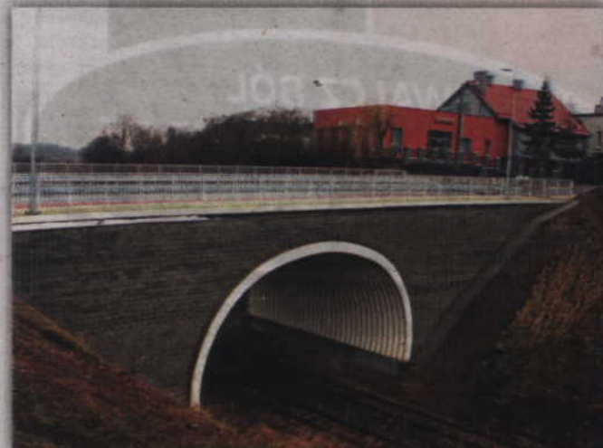
Nie tylko naprawiono i umocniono skarpy wiaduktu przy ul. Owczej, ale także zakończono wszystkie prace związane z budową dodatkowego odwodnienia na ulicach Długiej i Owczej. Fot. archiwum
