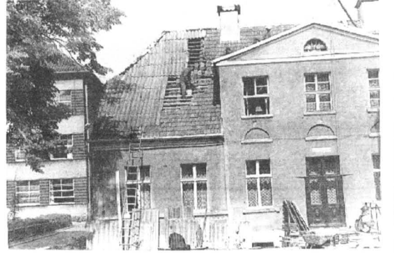
Z powodu ciągłych opadów deszczy prace dekarstw placówek oświatowych opóźniają się. Foto: J. K.
