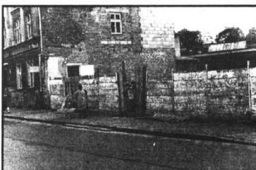
Nabudowany "plac zabaw" można wejść od ul. Bat. Chłopskich i od ul. Ogrodniczej
