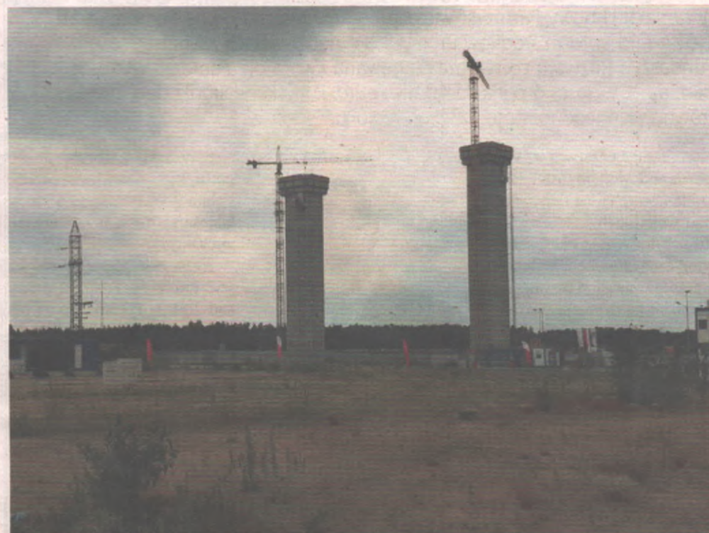
W miejscu widocznych na zdjęciu pylonów powstanie elektrownia gazowa w Ostrołęce.
