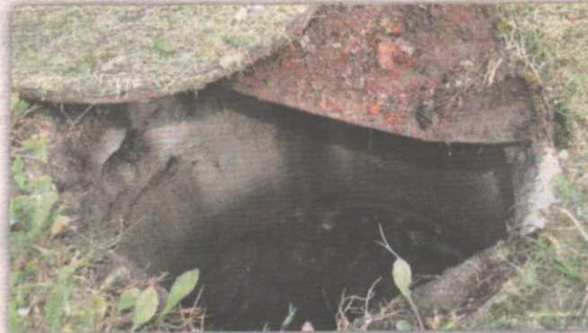
Strażacy podkreślają, że zdarzenie związane z ratowaniem psa pokazuje, że należy zwracać uwagę na odpowiednie zabezpieczenie szamb, studni, studzienek, kanałów i wykopów. W takich miejscach może bardzo często gromadzić się trujący siarkowodor.
