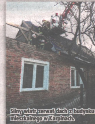
Przy pomocy dźwigu zdjęto uszkodzone i naderwane blachy i krokwie.
