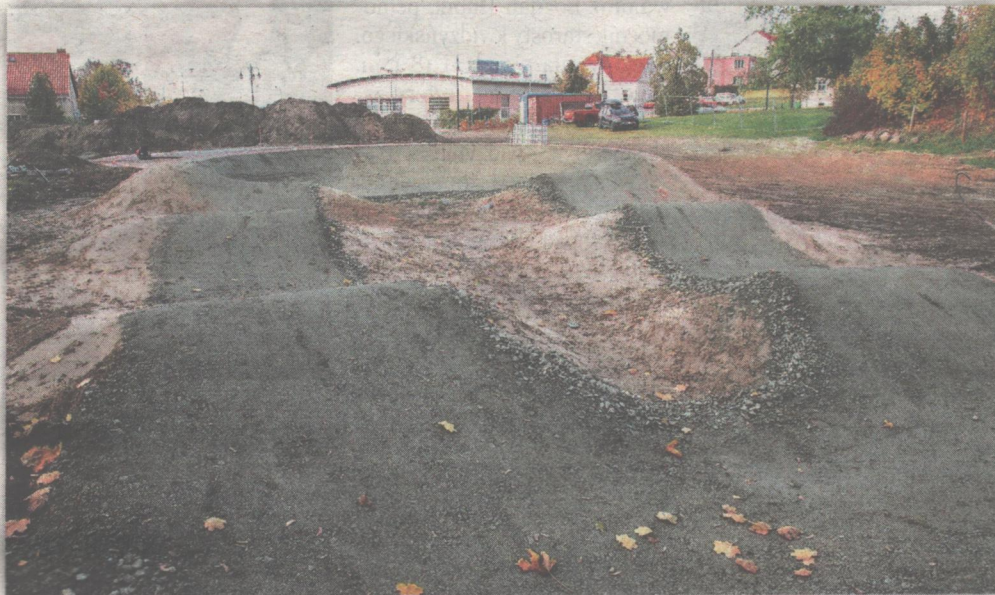
Na zdjęciu: stan budowy z września ubiegłego roku.
