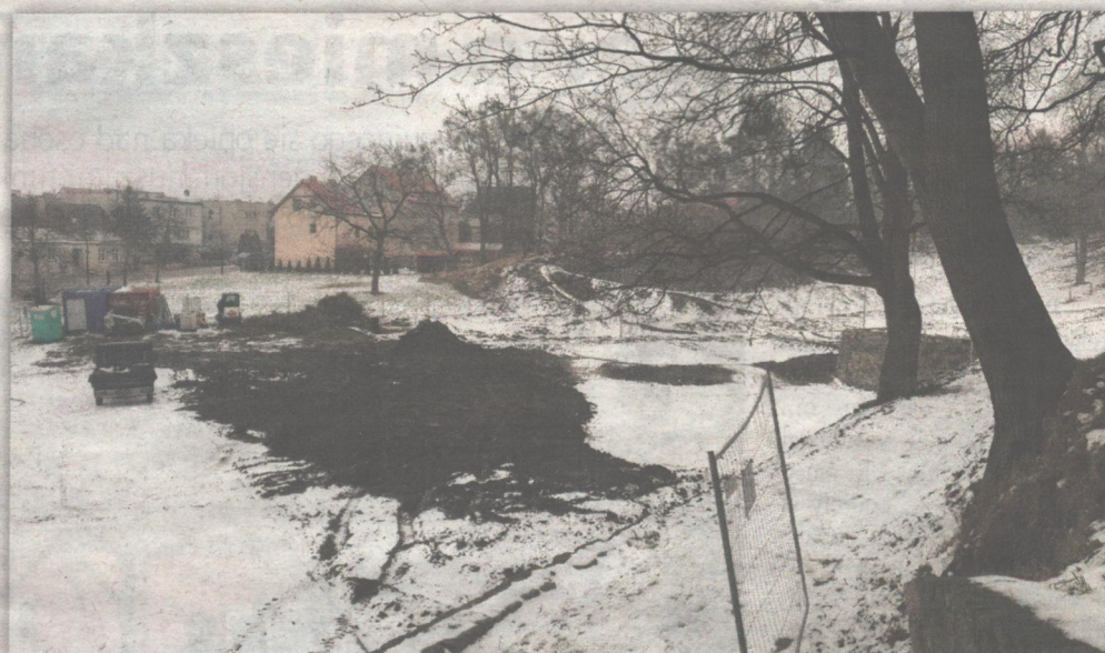
Przy ulicy Zamkowa Góra powstaje Park Rowerowy Kwidzyn. Obecnie wykonawca zmagają się z trudnymi warunkami pogodowymi.
