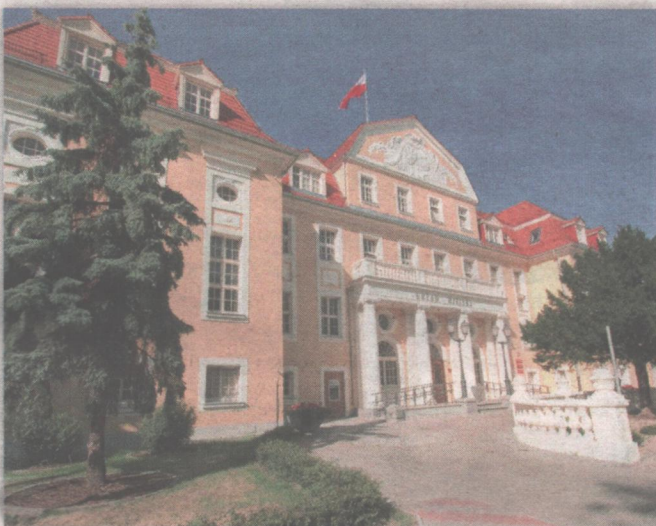
Samorząd miasta zaplanował w tym roku rozpoczęcie prac remontowych w siedzibie Urzędu Miejskiego. Fot. archiwum
