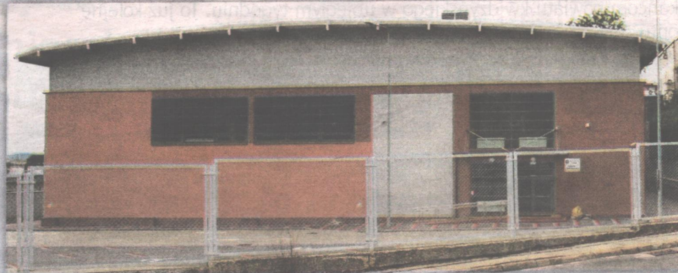
Hala sportowa przy ul. 11 Listopada Kwidzyńskiego Centrum Sportu i Rekreacji oraz hala sportowa Zespołu Szkół nr 2 przy ul. Żwirki i Wigury będą gotowe na przyjęcie uchodźców. Na zdjęciu: hala przy ul. Żwirki i Wigury. Fot. archiwum
