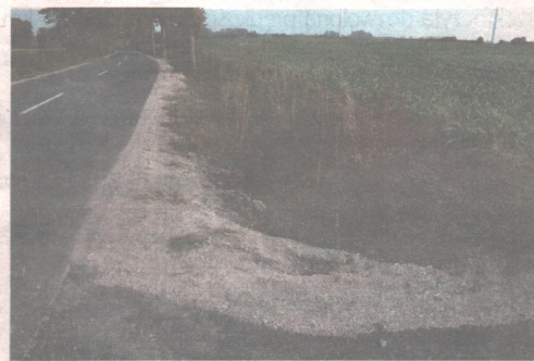
Pobocza wzmocniono sypkim żwirzem.
