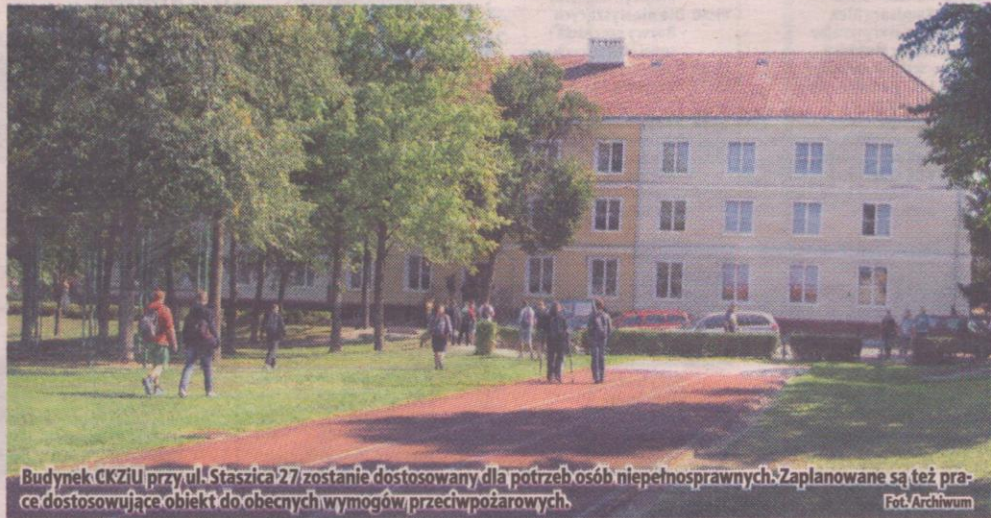
Dobiega końca przygotowanie dokumentacji dotyczącej modernizacji i rozbudowy budynków Centrum Kształcenia Zawodowego i Ustawicznego w Kwidzynie. Na zdjęciu: budynek CKZiU przy ul. Staszica 25.
