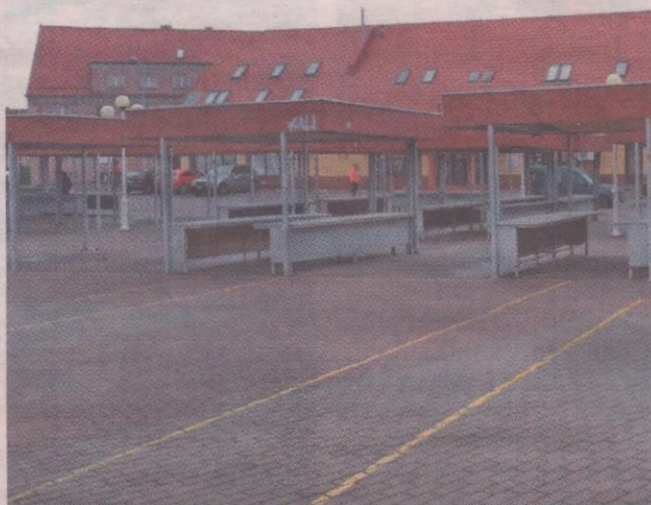
W tym roku zadaszone zostanie targowisko przy ul. Kopernika.
