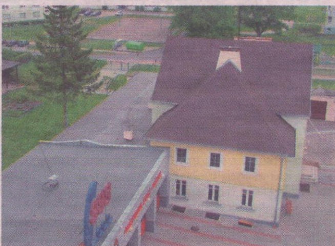
Dawną siedzibę Komendy Powiatowej Państwowej Straży Pożarnej w Kwidzynie czeka remont. Prace mają rozpocząć się w tym roku.
