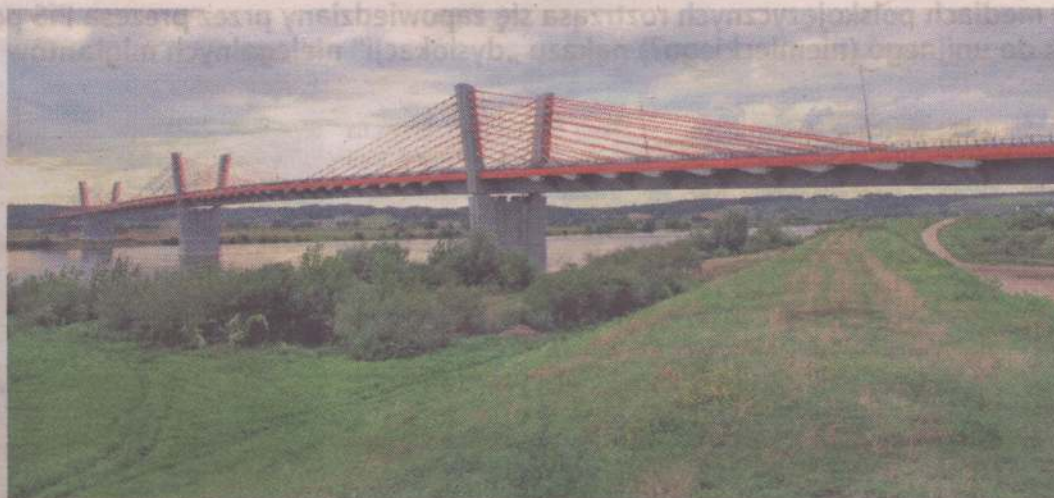
Most przez Wisłę w okolicy Kwidzyna to największa konstrukcja typu extradosed (z ang. Extradosed prestressed bridge) w Europie oraz jedna z największych na świecie. Ma ponad 800 m długości. Rozpiętość przęsła wynosi 204 m. Fot. archiwum
