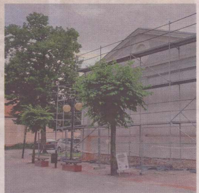
Zakończono już wykonywanie izolacji pionowej budynku od strony ul. Szkolnej oraz prace związane z dociepleniem.
