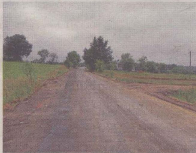
Zakres prac na drodze powiatowej Wandowo-Rozajny jest większy, gdyż prace obejmują wykonanie podbudowy drogi.
