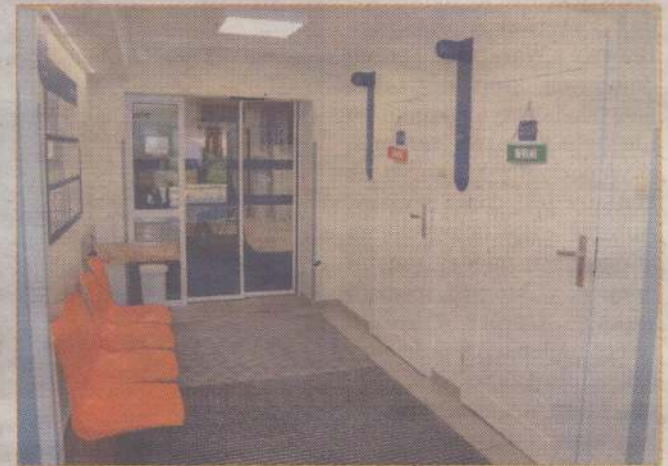
Wykonano dwie pary drzwi przesuwanych, także po to, by ułatwić dostęp do budynku osobom niepełnosprawnym. Dla potrzeb osób niepełnosprawnych dostosowano łazienki.
